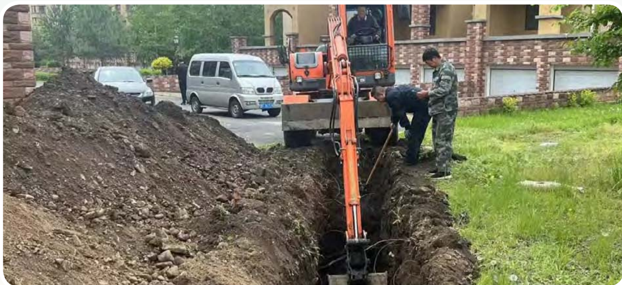
区供水服务中心维修水管
